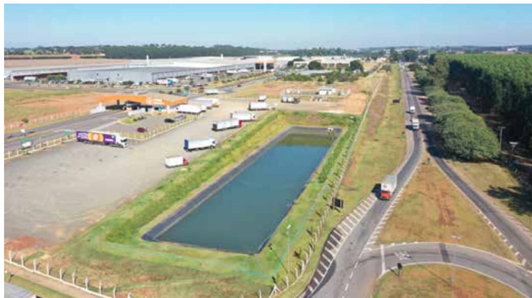
Reservatório Veiling: 11 milhões litros água chuva
