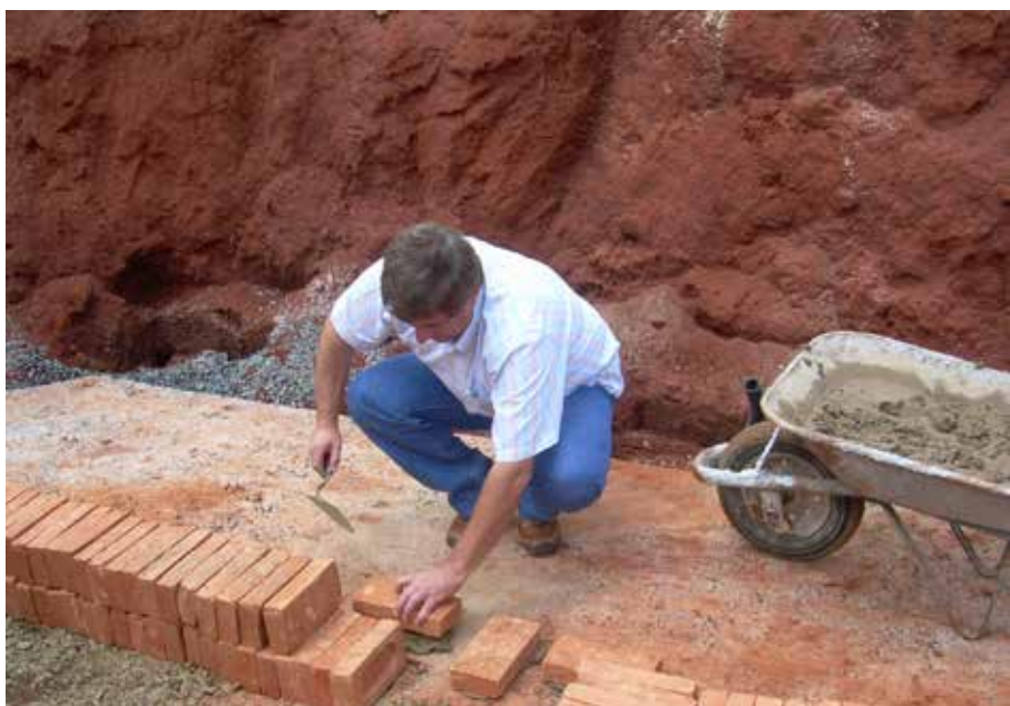
Prefeito Celso Capato simbolicamente dando início às obras
