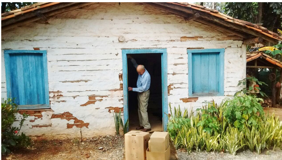
Jan Eltink antes da demolição da casa de pau a pique: portas, batentes e janelas serão reaproveitados na nova construção
